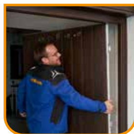
Demontaż i ekologiczna utylizacja
